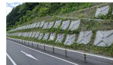
受圧板+アンカー
