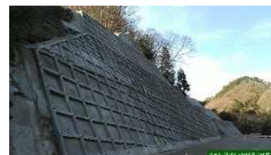
法枠+鉄筋挿入
