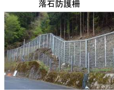
高エネルギー型吸収落石防護柵
