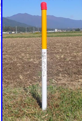
中心目印杭設置状況
