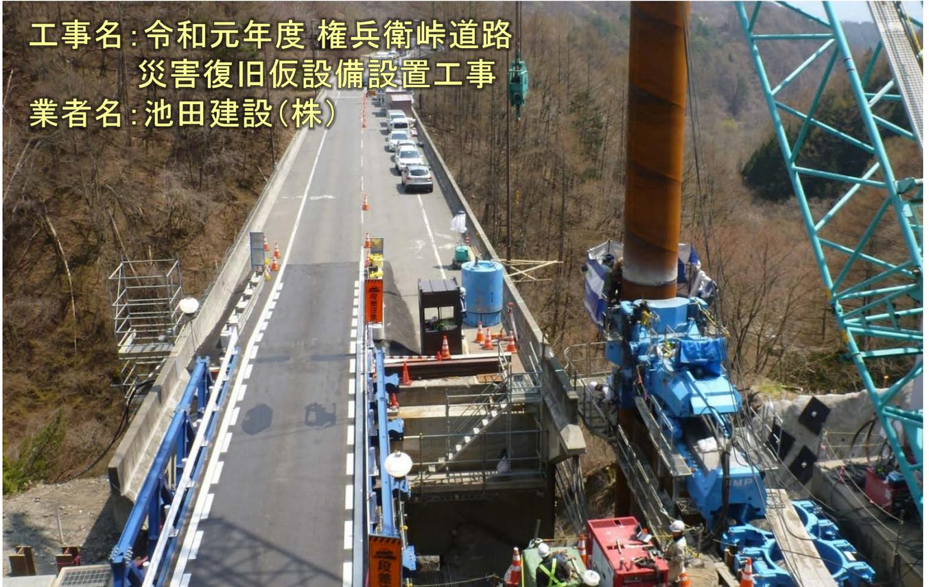
現場の施工状況(斜面土留のため鋼管を打ち込み中)【4月17日】
