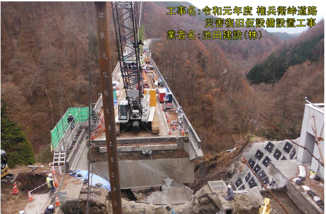
現場の施工状況(仮橋基礎の施工)【11月26日】
