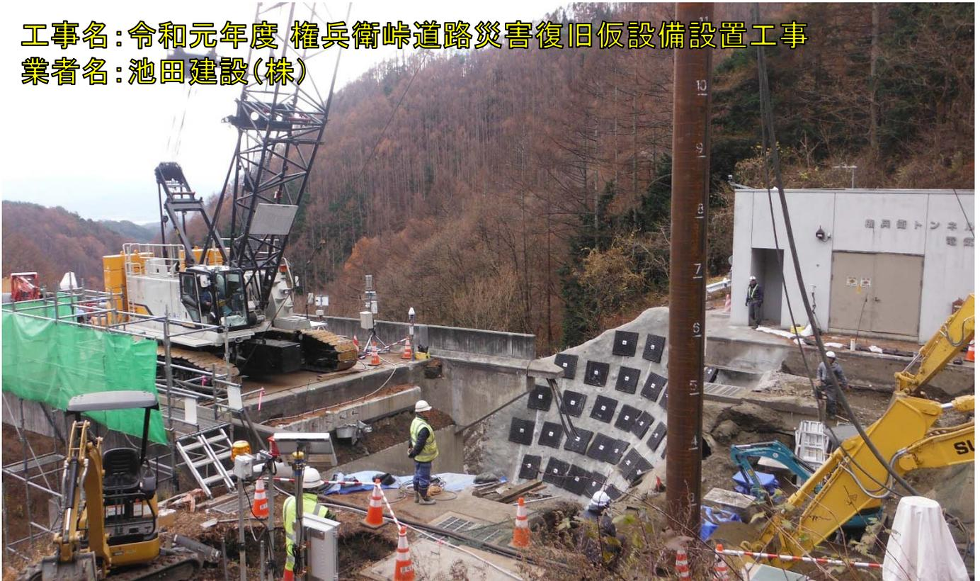
現場の施工状況(仮橋基礎の施工)【11月26日】
