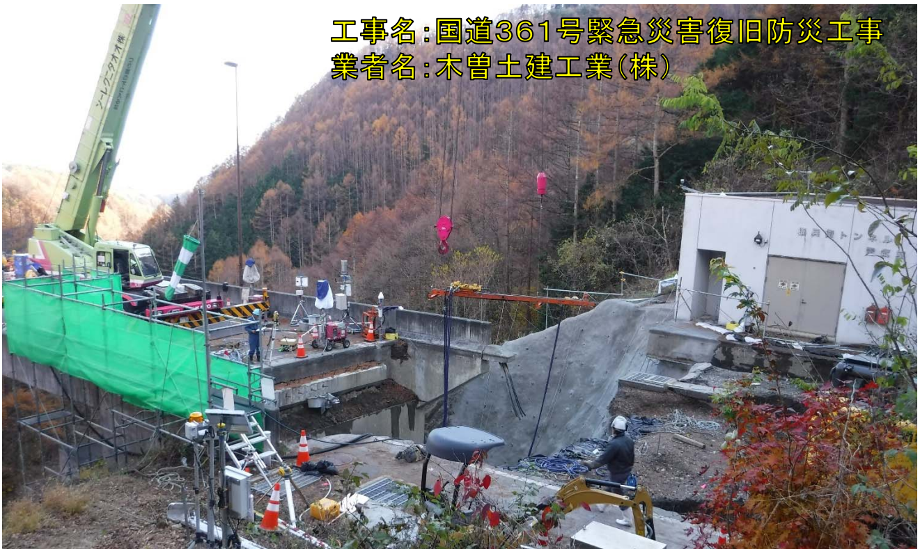
現場の施工状況【11月19日】
