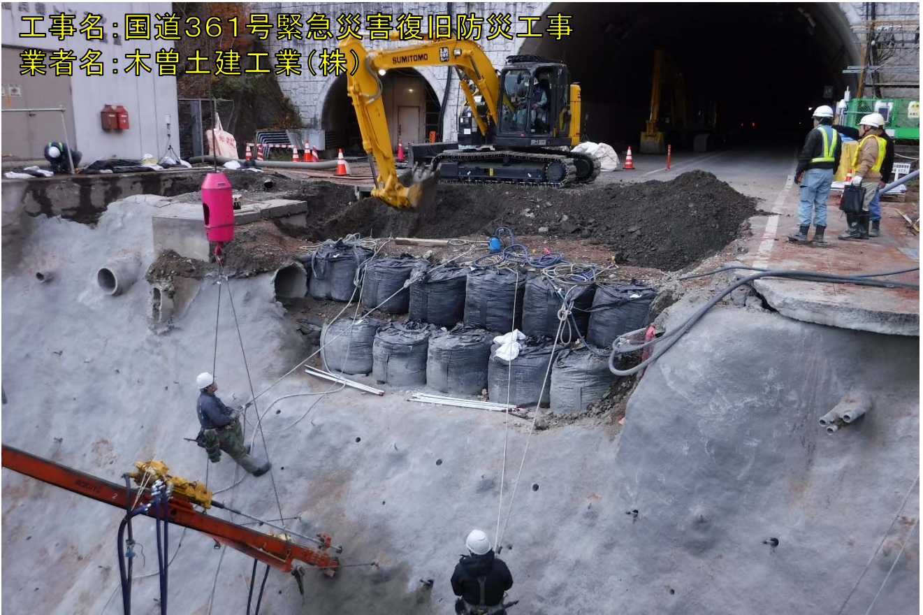
崩落面の補強状況【11月19日】
