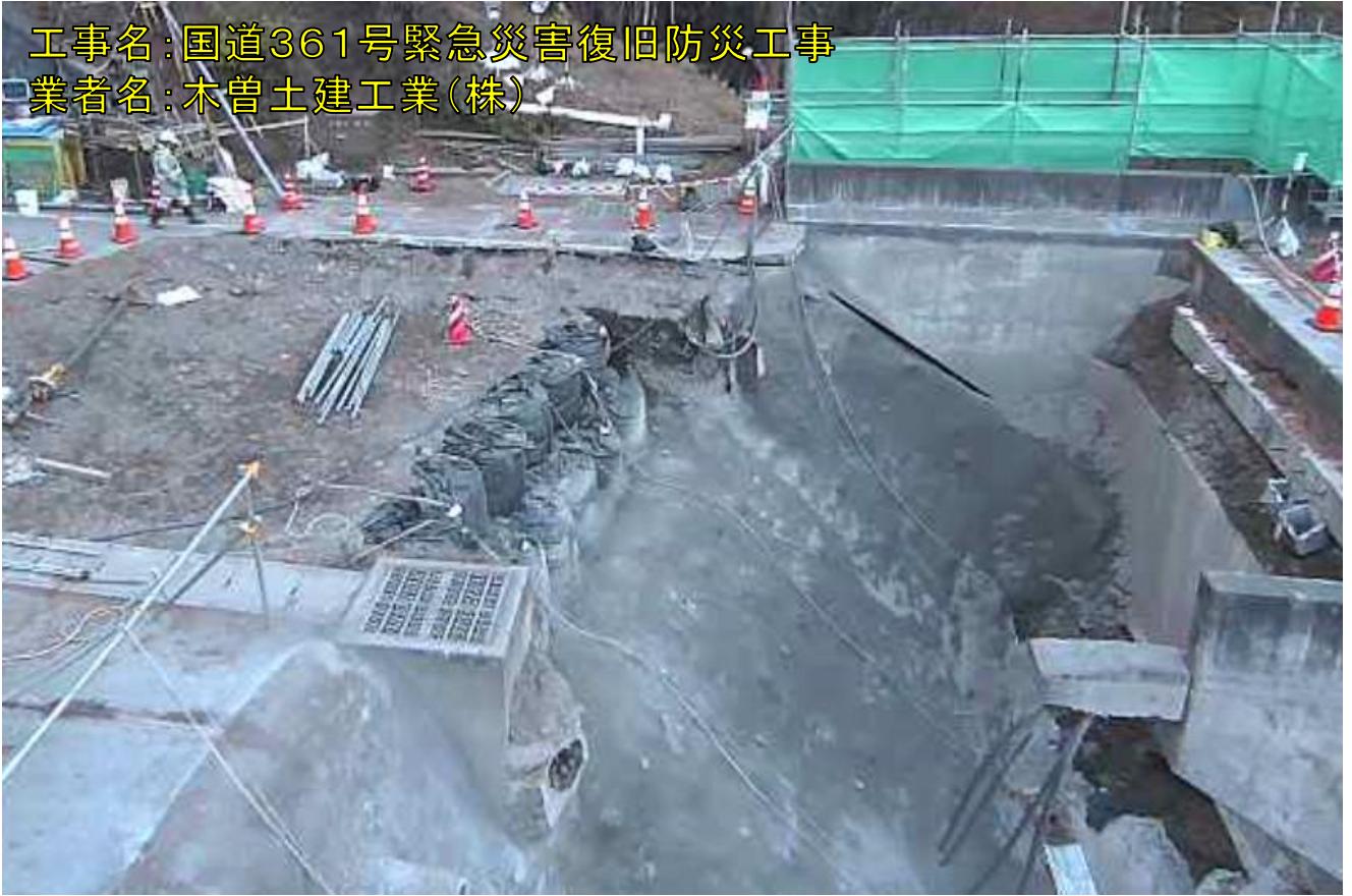
崩落面の補強状況(コンクリート吹付けを実施)【11月18日】
