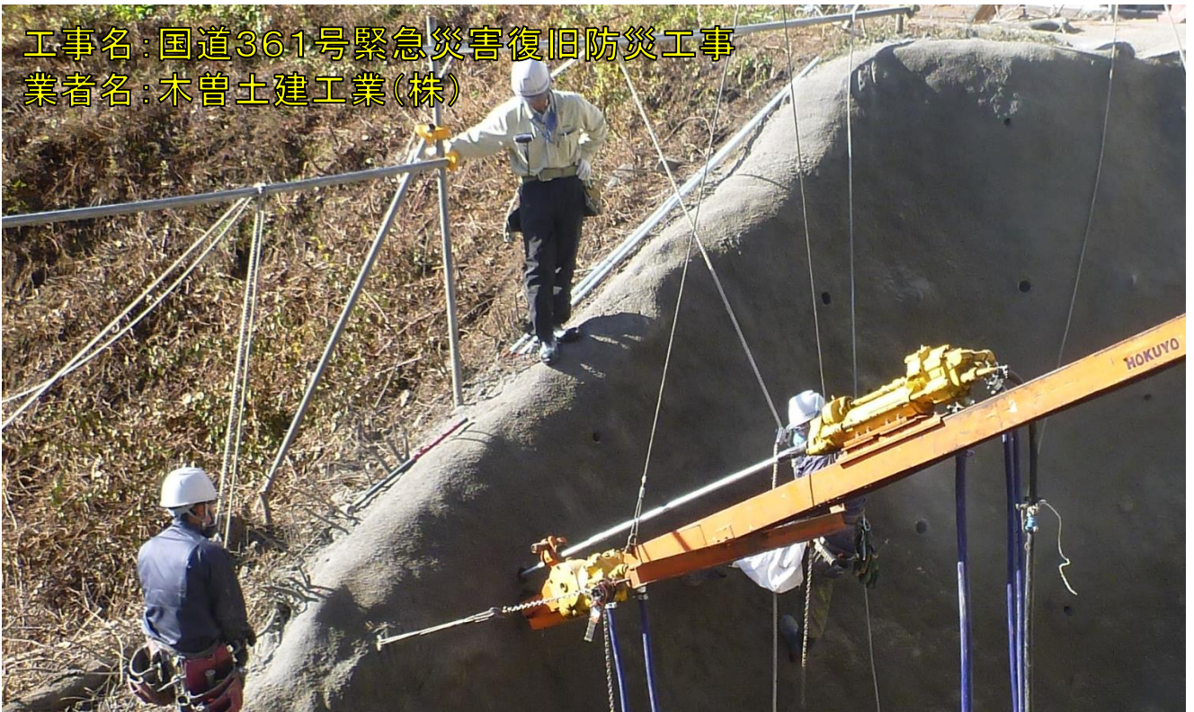
崩落面の補強作業(アンカーを打込み中)【11月18日】
