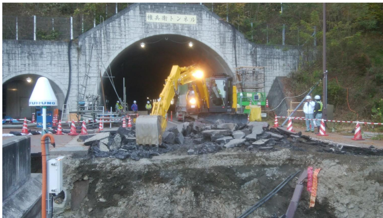
崩落部撤去作業(11月8日)
