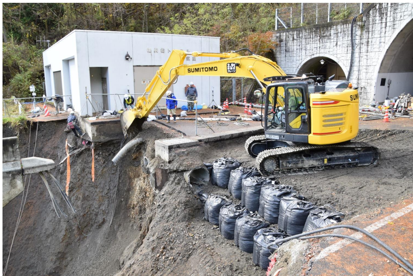
崩落部撤去作業(11月14日)
