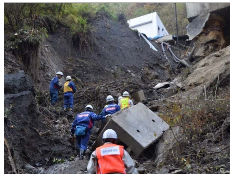
現地調査状況
