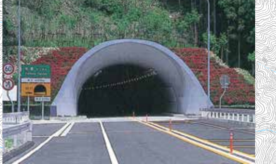
矢野トンネル程野側坑口
