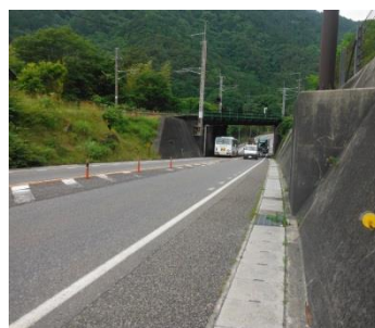
棧地区歩道設置(上松町)
