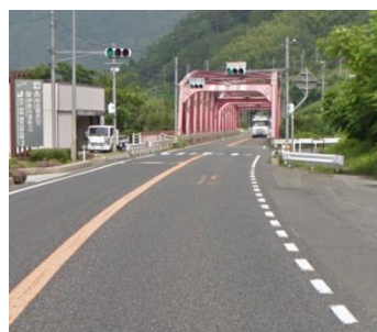
伊奈川橋交差点改良(大桑村)
