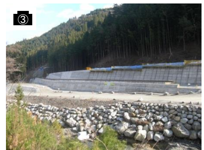
③ 小嵐工事用道路
