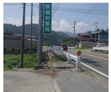
駒場地区歩道設置(阿智村)
