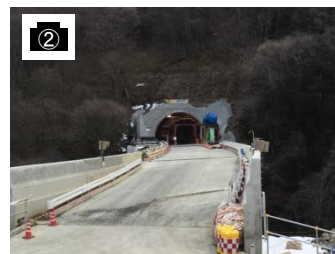
トンネル坑口
