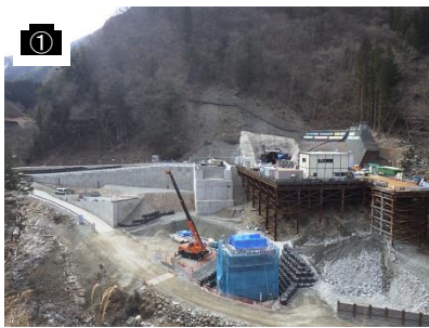
① 長野県側調査坑(坑口)
