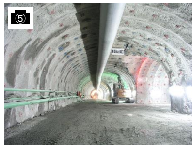
⑤ 静岡県側調査坑(坑内)
