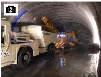
② 長野県側調査坑(坑内)
