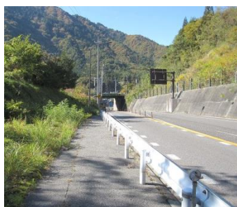
棧地区歩道設置(上松町)
