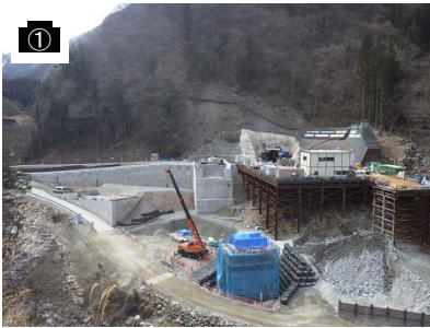
① 長野県側調査坑(坑口)
