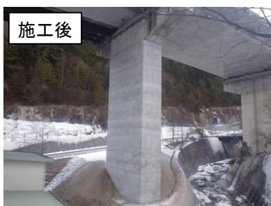
橋梁耐震補強
