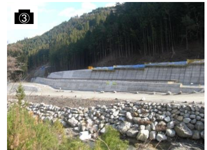
③ 小嵐工事用道路
