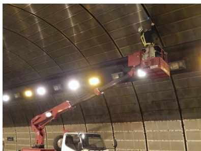
トンネル点検
