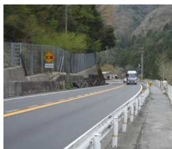
神戸地区視距改良(南木曾町)
