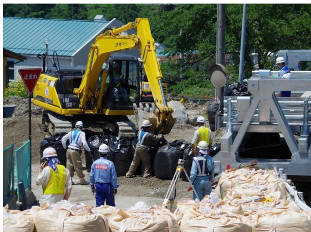
南木曾町土石流災害 応急組立橋設置支援(H26.7)
