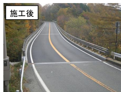
橋梁修繕(床版)
