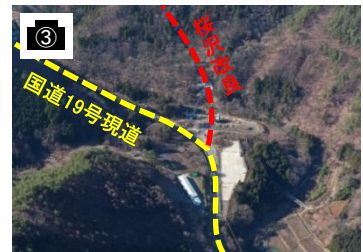
桜沢改良終点部全景
