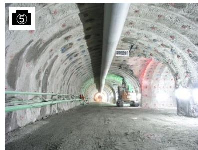
⑤ 静岡県側調査坑(坑内)
