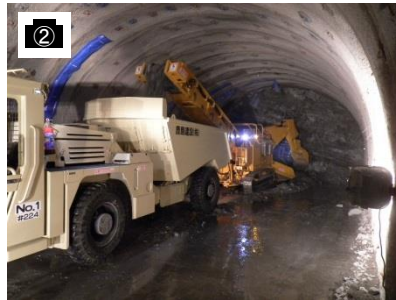
② 長野県側調査坑(坑内)
