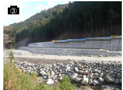
③ 小嵐工事用道路
