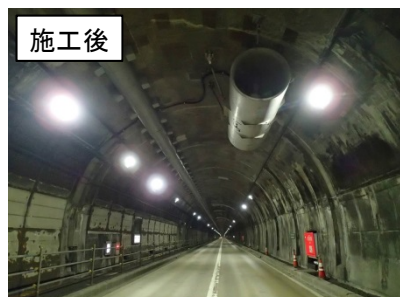
鳥居トンネル天井板撤去
