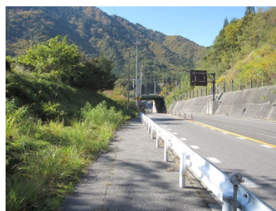
棧地区歩道設置(上松町)
