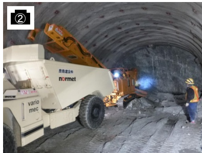
② 長野県側調査坑(坑内)
