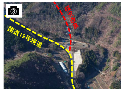
桜沢改良終点部全景
