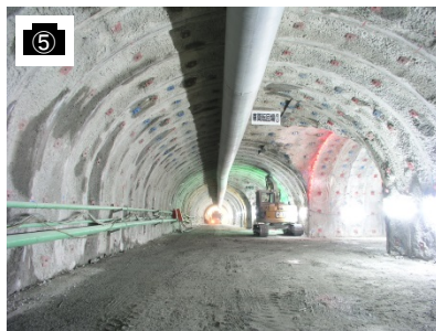
⑤ 静岡県側調査坑(坑内)
