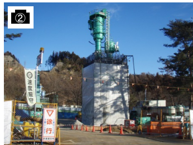
4号橋 P15橋脚
