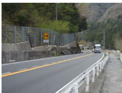
神戸地区視距改良(南木曾町)
