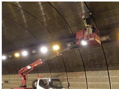
トンネル点検
