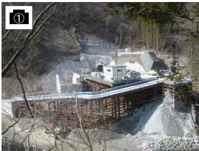
① 長野県側調査坑(坑口)
