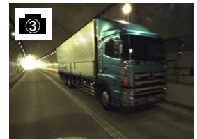
③ 開通区間(トンネル部)
