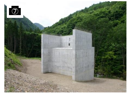
2号橋 A2橋台
