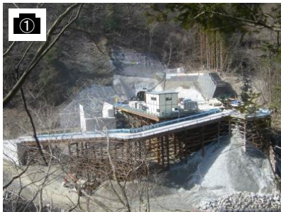
① 長野県側調査坑(坑口)
