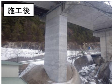
橋梁耐震補強
