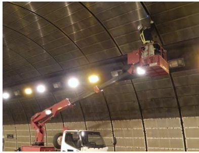
トンネル点検
