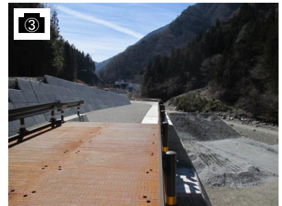
③ 小嵐工事用道路
