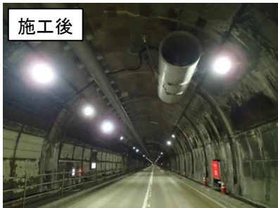
鳥居トンネル天井板撤去
