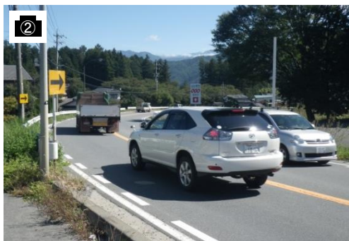
線形不良箇所
