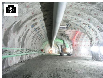
⑤ 静岡県側調査坑(坑内)
