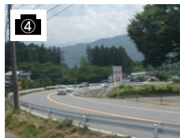
現道の線形不良箇所
