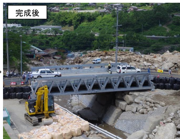
南木曾町県道264号梨子沢橋 応急組立橋の設置状況
