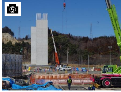
4号橋 P11橋脚
