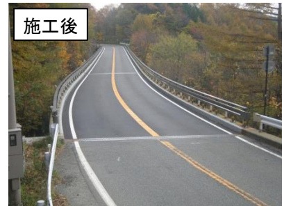
橋梁修繕(床版)
