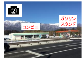
開通区間の状況②
