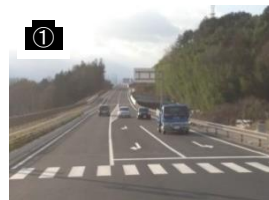
開通区間の状況①
