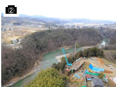
天龍峡大橋左岸側
