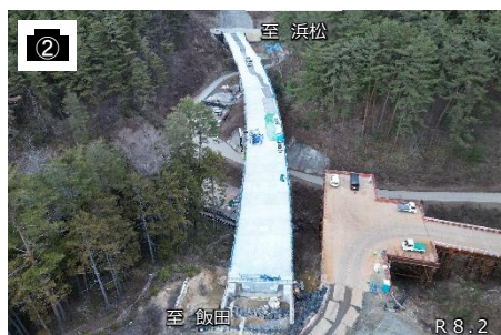
3号橋施工状況
