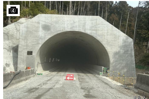
静岡県側本坑(坑口)
