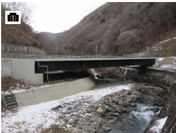
橋梁上部施工状況
