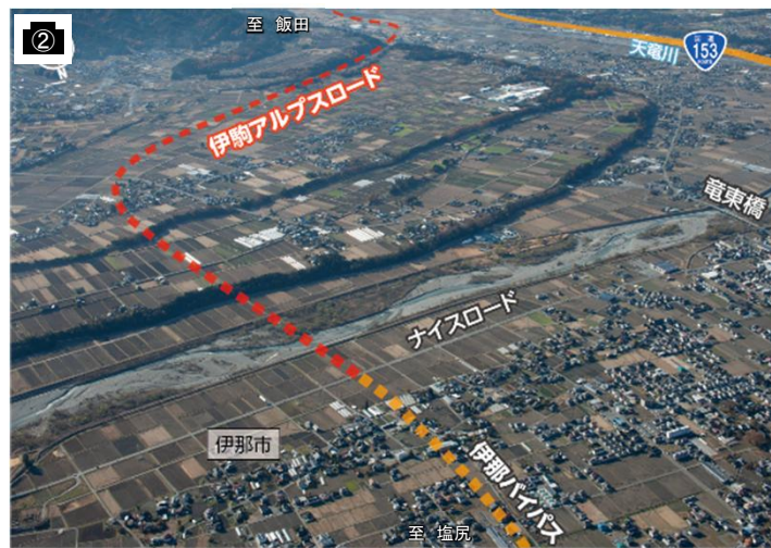
終点側から起点側を望む
