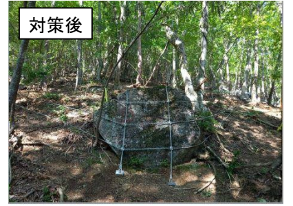
落石防止網工
