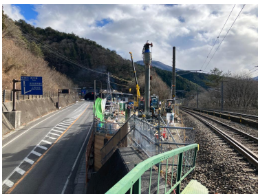
かけはし 棧地区歩道設置(上松町) 工事中
