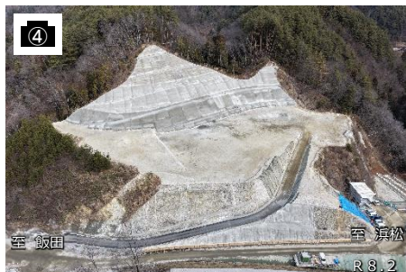
氏乗IC(仮称)付近施工状況
