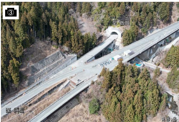
静岡県側本坑(坑口)周辺
