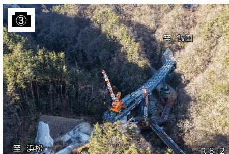
4号橋施工状況
