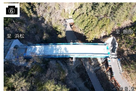
6号橋施工状況
