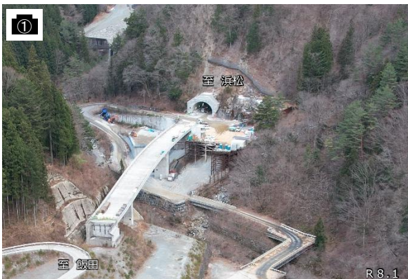
長野県側本坑(坑口)周辺
