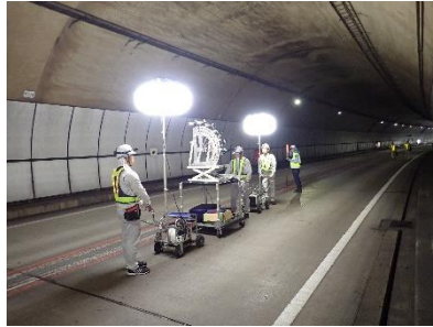
トンネル点検
