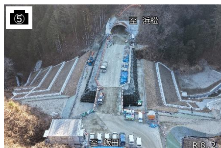
2号トンネル施工状況
