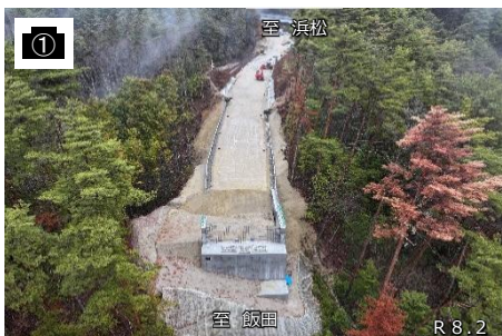
2号橋施工状況
