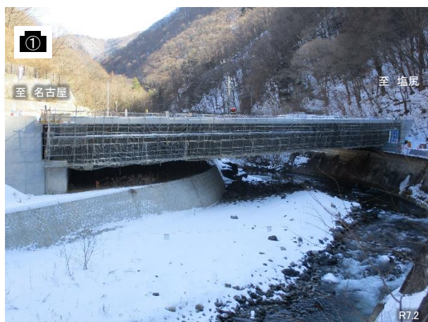
橋梁上部施工状況
