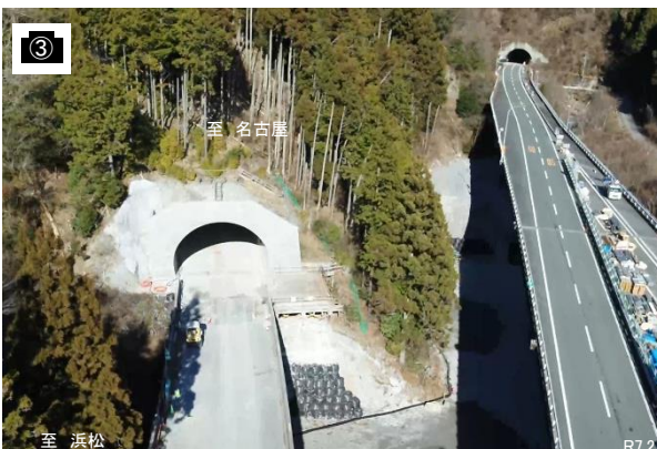
静岡県側本坑(坑口)周辺
