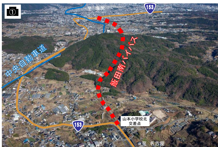
起点側から終点側を望む
