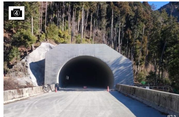
静岡県側本坑(坑口)
