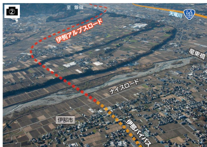
終点側から起点側を望む
