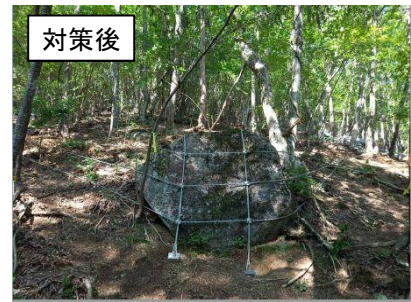
落石防止網工
