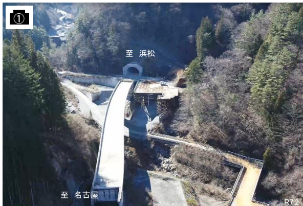
長野県側本坑(坑口)周辺
