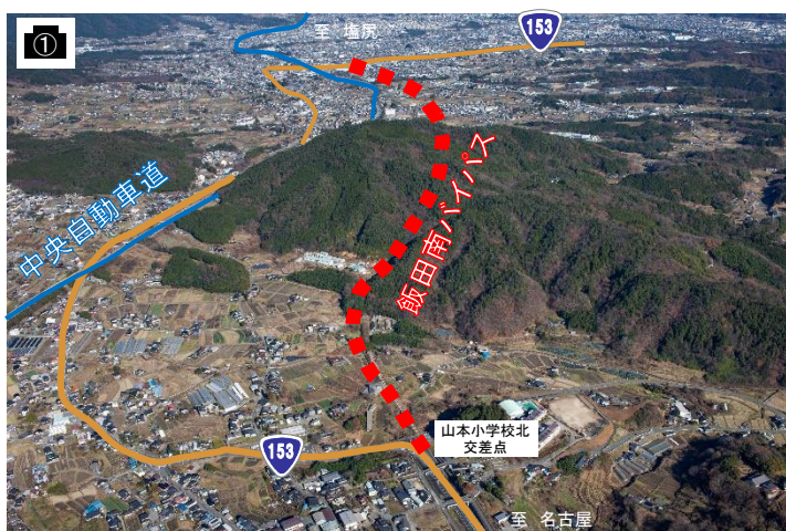
起点側から終点側を望む
