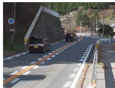
ならいがわ 奈良井川橋交差点改良(塩尻市) 設計中
