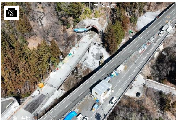
静岡県側本坑(坑口)周辺
