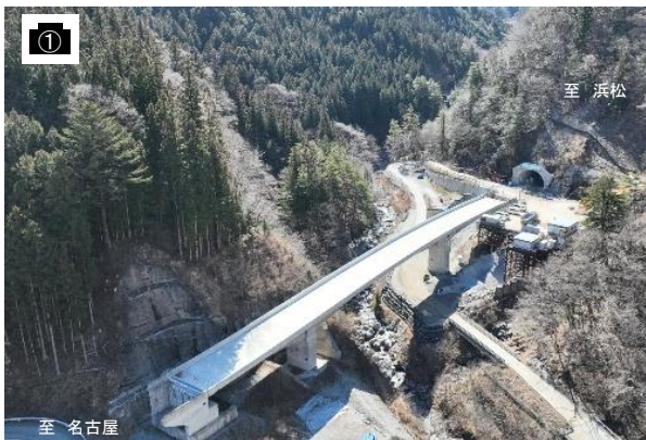
長野県側本坑(坑口)周辺
