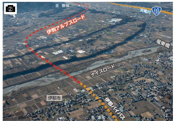
終点側から起点側を望む
