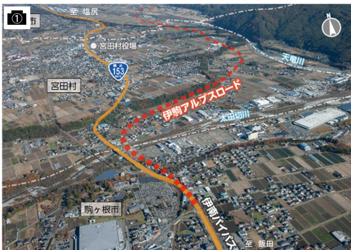
起点側から終点側を望む
