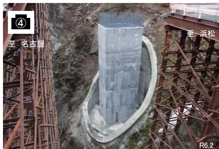
7号橋施工状況
