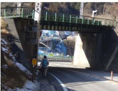
かけはし 棧地区歩道設置(上松町) 工事中
