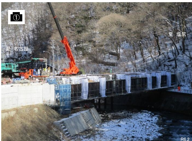
橋梁上部施工状況
