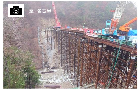
8号橋付近施工状況
