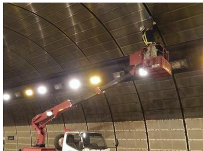
トンネル点検
