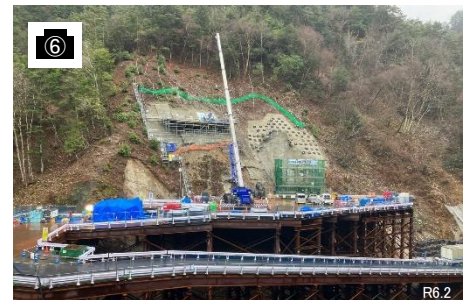
6号トンネル施工状況
