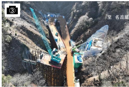
6号橋施工状況
