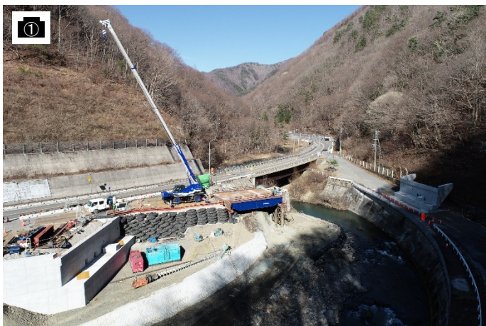
橋梁上部施工状況
