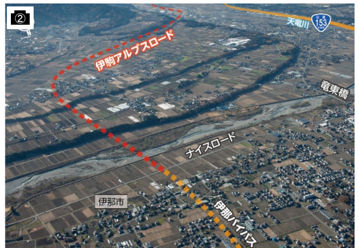
終点側から起点側を望む
