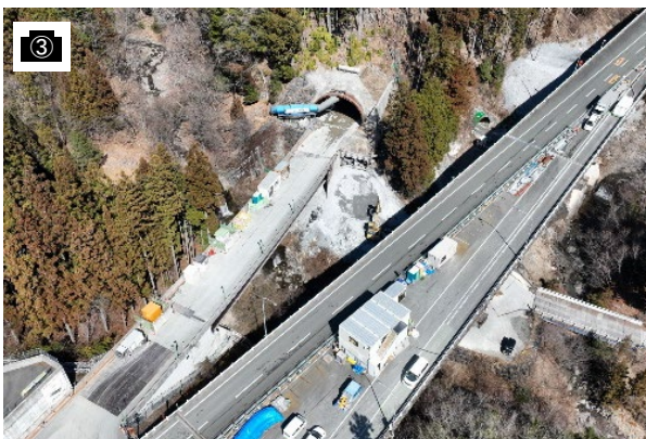
静岡県側本坑(坑口)周辺
