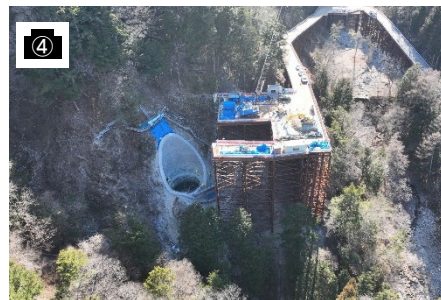
7号橋施工状況
