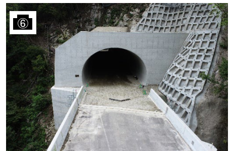
11号トンネル(喬木IC付近)
