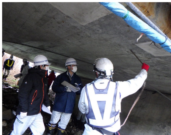
橋梁点検現地講習
