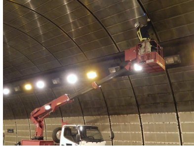
トンネル点検
