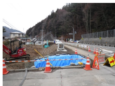
ひらさわ 平沢地区交差点改良(塩尻市) 工事中
