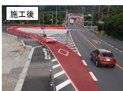
交差点改良 (右折導流路設置)
