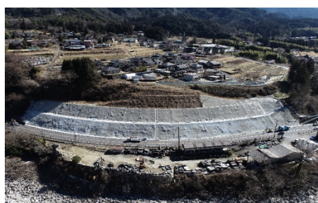
ごうど 神戸地区視距改良(南木曾町) 工事中
