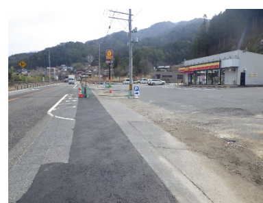
のじり 野尻地区交差点改良(大桑村) 工事中
