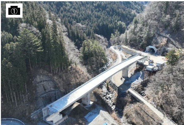
長野県側本坑(坑口)周辺
