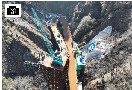
6号橋施工状況
