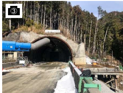
静岡県側本坑(坑口)
