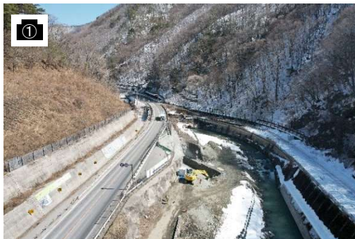
起点側の様子
