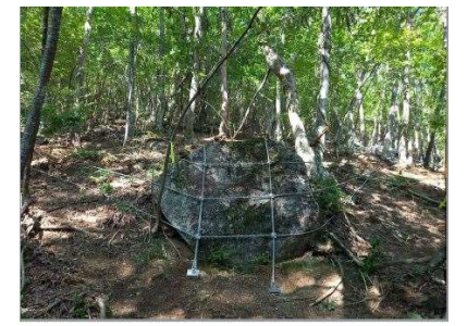
落石防止網工
