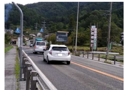
野尻地区交差点改良(大桑村)
