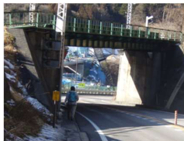
棧地区歩道設置(上松町)
