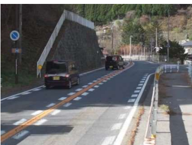
奈良井川橋交差点改良(塩尻市)
