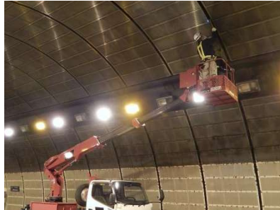
トンネル点検
