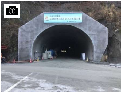
長野県側本坑(坑口)
