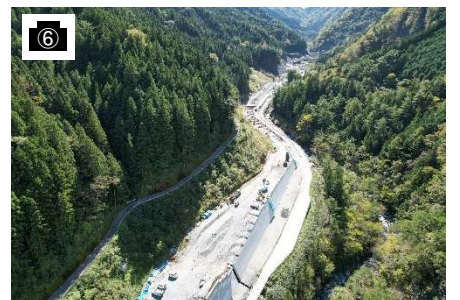
小嵐工事用道路
