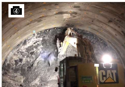
静岡県側本坑(坑内)
