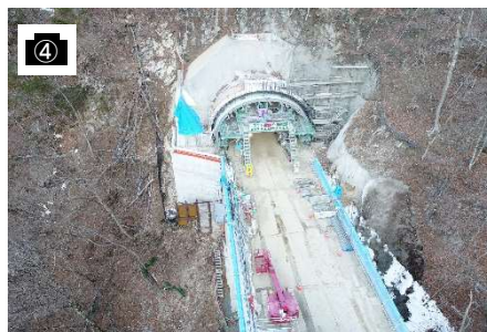
④ 喬木IC付近(11号トンネル)
