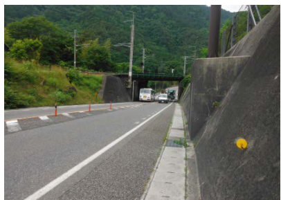
棧地区歩道設置(上松町)
