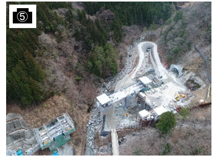
本線橋施工の様子
