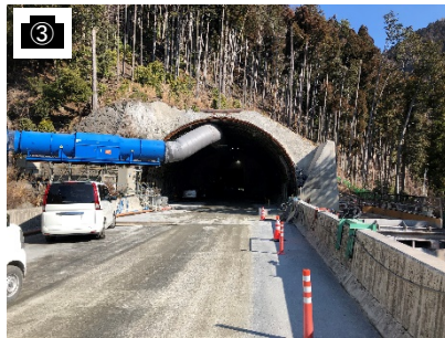
静岡県側本坑(坑口)
