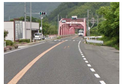
伊奈川橋交差点改良(大桑村)
