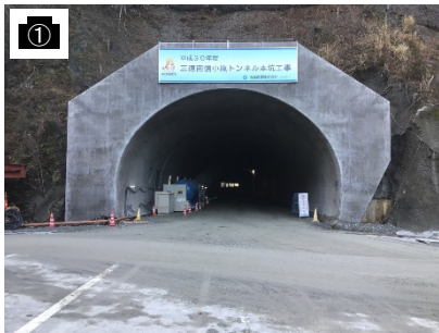
長野県側本坑(坑口)
