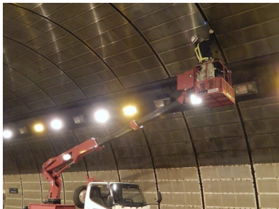
トンネル点検
