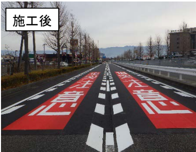
交通安全対策 (ドットライン・カラー舗装)
