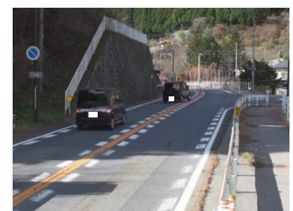
奈良井川橋交差点改良(塩尻市)
