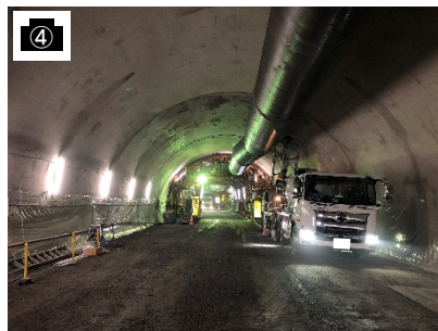
静岡県側本坑(坑内)
