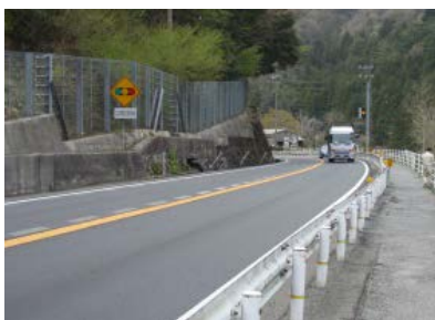
神戸地区視距改良(南木曾町)
