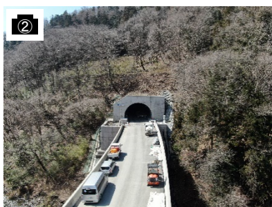
トンネル坑口(塩尻側)
