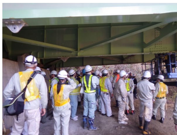
橋梁点検現地講習
