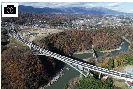
① 天龍峡大橋(R1.11開通)
