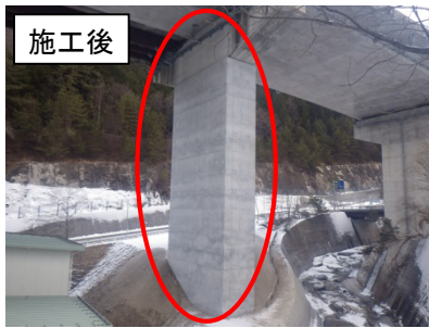
橋梁耐震補強 (コンクリート巻き立て)
