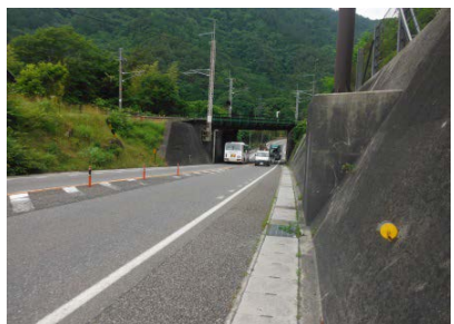
棧地区歩道設置(上松町)
