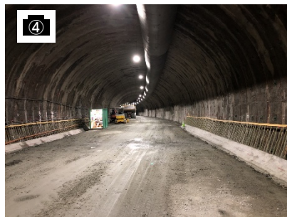
④ 静岡県側本坑(坑内)
