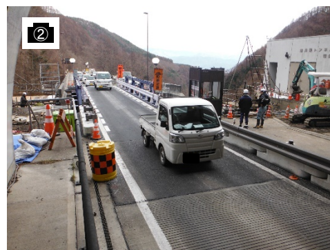
仮復旧の様子
