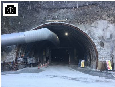
① 長野県側本坑(坑口)
