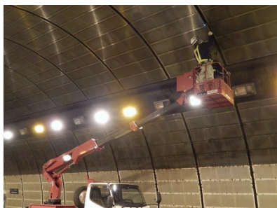
トンネル点検
