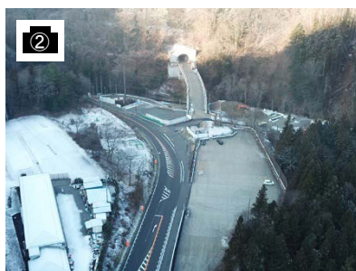
トンネル坑口(塩尻側)
