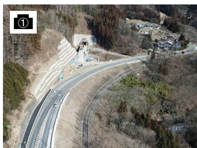
トンネル坑口(名古屋側)
