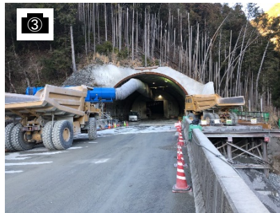
③ 静岡県側本坑(坑口)
