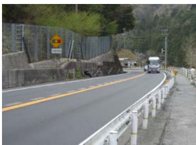
神戸地区視距改良(南木曾町)
