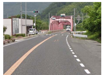
伊奈川橋交差点改良(大桑村)
