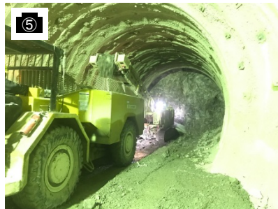
静岡県側調査坑(坑内)
