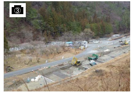
小嵐工事用道路
