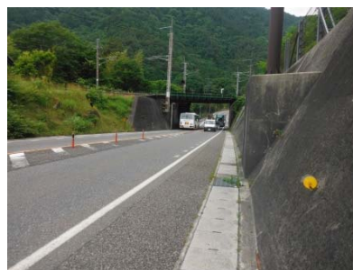
棧地区歩道設置(上松町)
