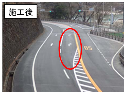
交差点改良 (右折レーン設置)
