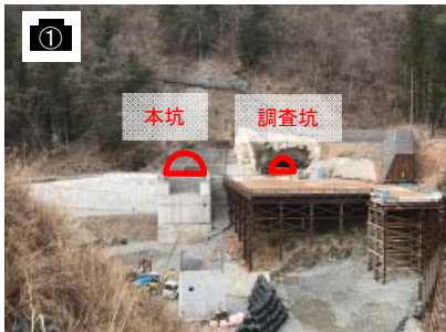
長野側本坑(坑口)
