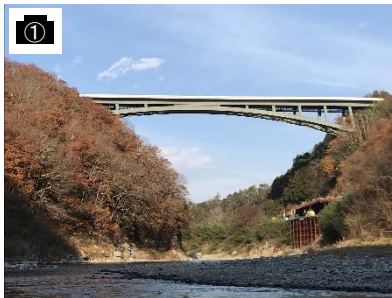
天龍峡大橋(仮称)
