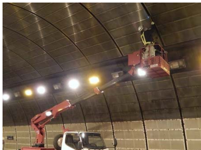
トンネル点検
