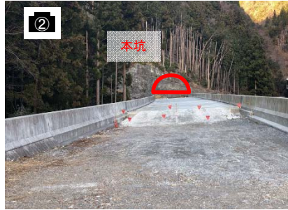
静岡県側本坑(坑口)
