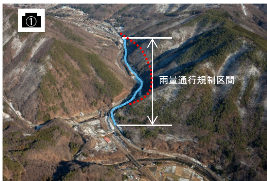
起点側の様子
