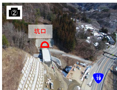
トンネル坑口(名古屋側)
