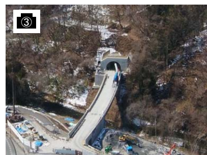
トンネル坑口(塩尻側)
