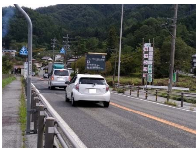
野尻地区交差点改良(大桑村)
