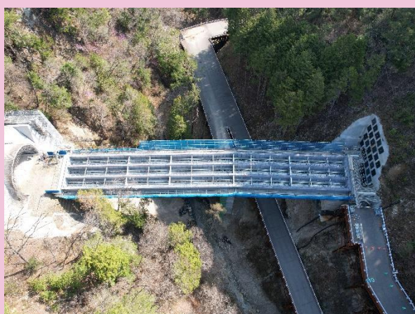
施工状況（6号橋床板工）
