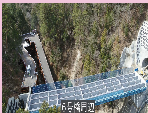
施工状況（6号橋床板工）
