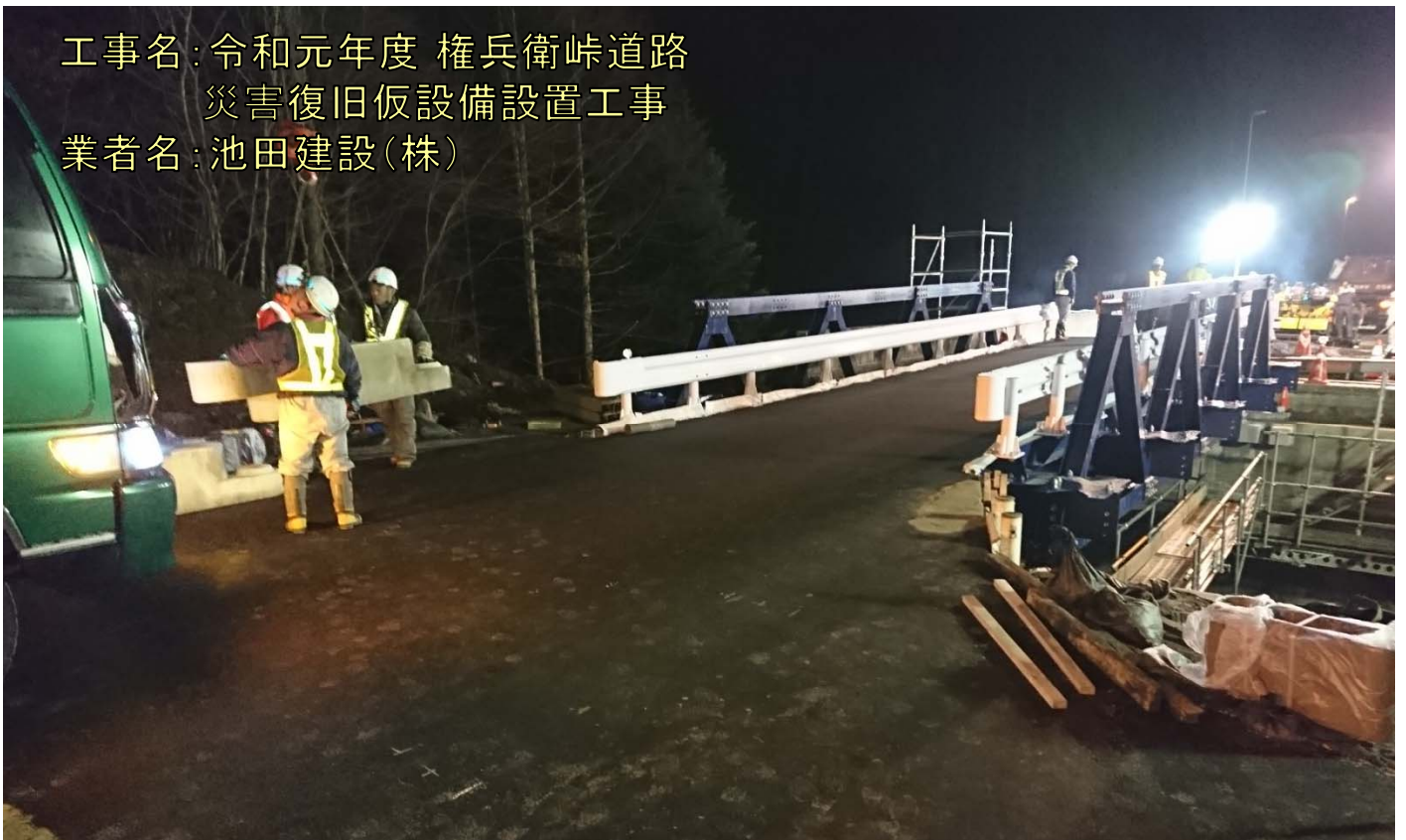
仮橋の施工状況【12月18日】
