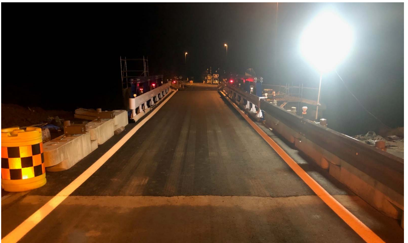
舗装整備状況【12月19日】
