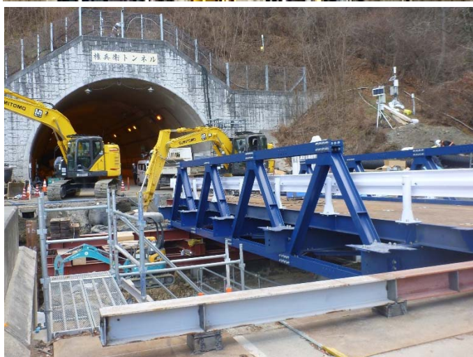
仮橋の架設状況【上段:12月13日 下段:12月12日】
