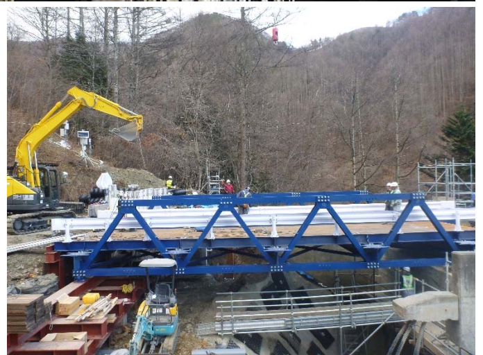
仮橋の架設状況【上段:12月13日 下段:12月12日】
