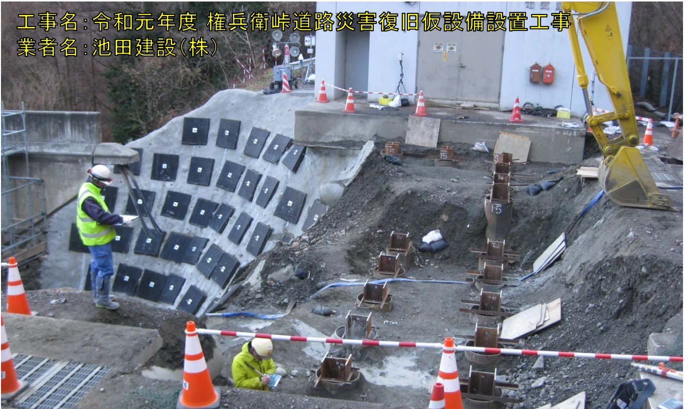
現場の施工状況(仮橋基礎の施工)【12月3日】
