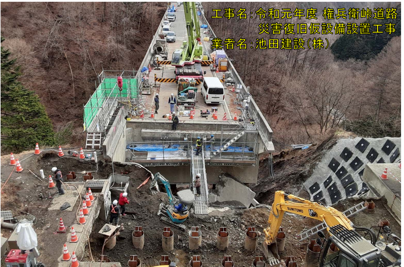
施工現場の状況【12月5日】
