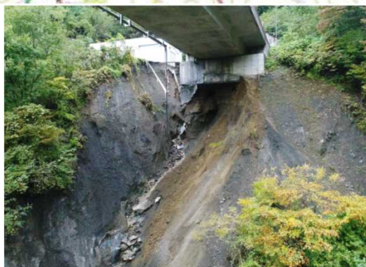
▲土砂崩落状況(橋梁下方より撮影)
