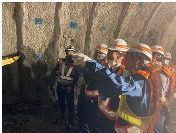
現場確認状況
