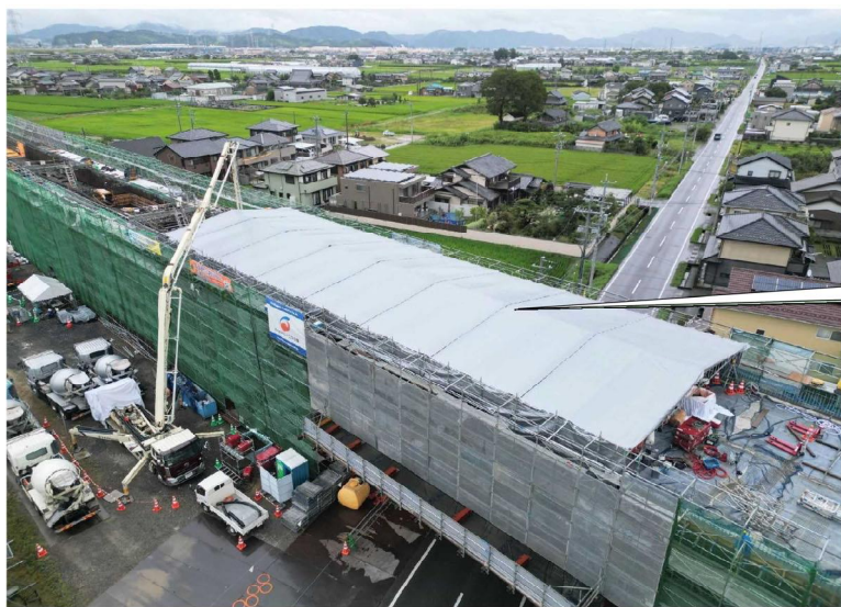
雨よけ(テント)設置によって天候に影響を受けないコンクリートの打設(近接高架橋での実施例)
