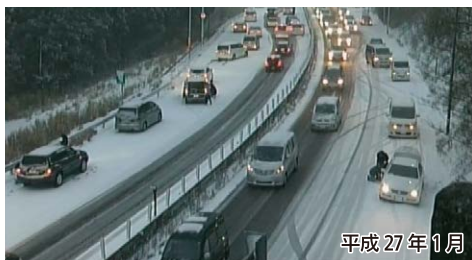
名阪国道 南在家IC付近
