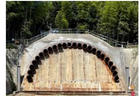
パイプルーフ全景 川越方から鈴鹿方を望む
