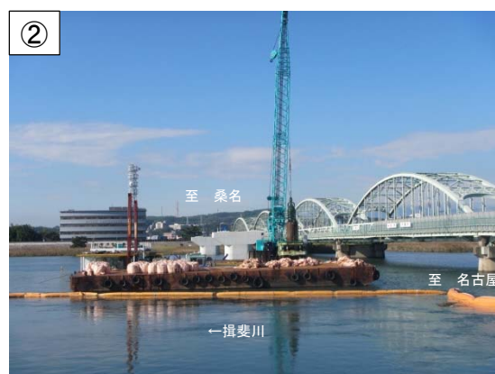
中堤より揖斐川を望む
