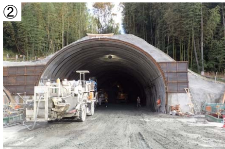
坂部トンネル（仮称）坑口より川越方面を望む
