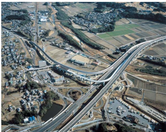
関バイパス 名阪接続ランプ
