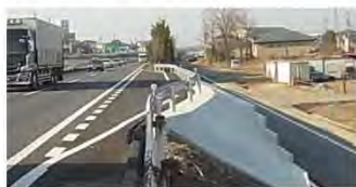
対策例:非常駐車帯の整備(新設)
