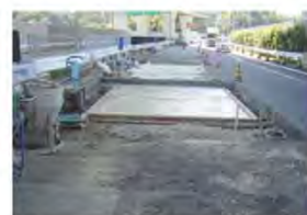
踏掛版工完成
