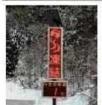
対策例: LED電光表示板の設置
