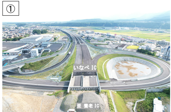
いなべICより大安方面を望む (R7.9)
