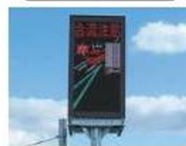
対策例: 合流車情報板の設置
