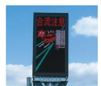
対策例：合流車情報板の設置
