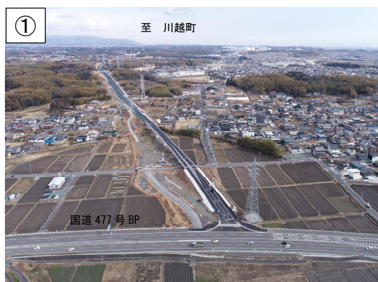
国道 477 号 BP から川越方面を望む (R7.2)
