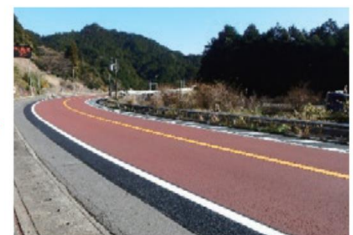
カラー舗装後
