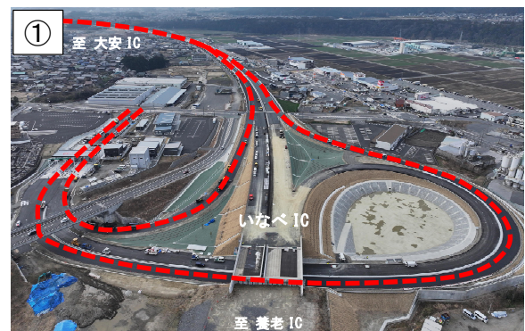
いなべICより大安方面を望む (R7.2)
