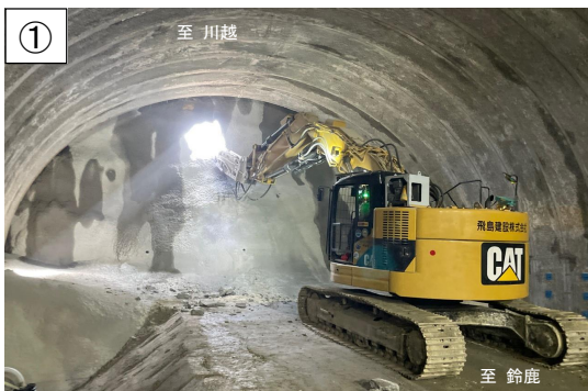
坂部トンネル貫通 (R5.10)
