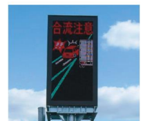
対策例：合流車情報板の設置
