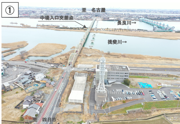
四日市側より名古屋方面を望む (R6. 2)
