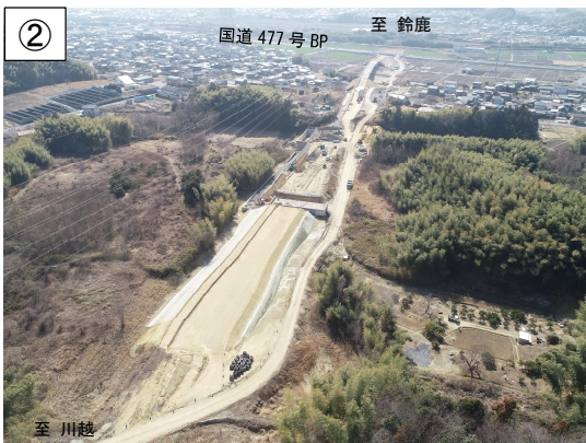
国道477号BPから川越方面を望む (R6.2)
