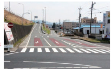
進入禁止カラー舗装
