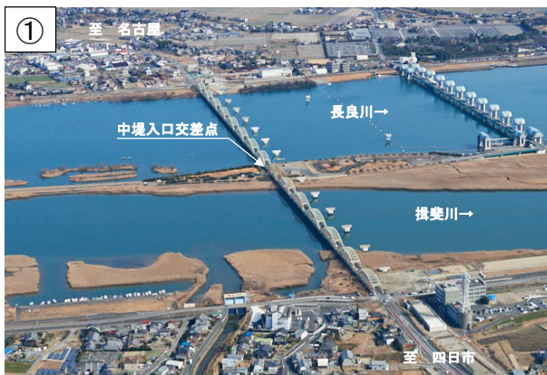
四日市側より名古屋方面を望む
