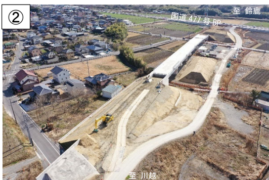
川越方面から国道477号BPを望む
