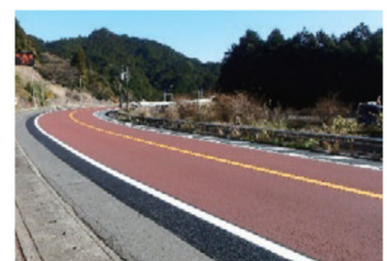
カラー舗装後
