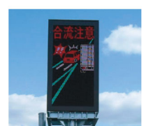
対策例：合流車情報板の設置
