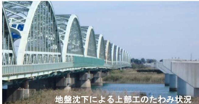
地盤沈下による上部工のたわみ状況
