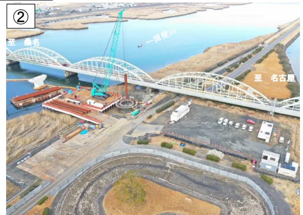
中堤より揖斐川を望む
