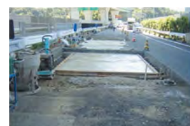
踏掛版工完成
