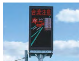
対策例:合流車情報板の設置
