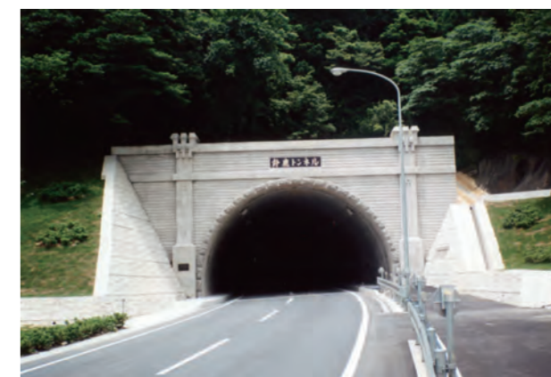
鈴鹿トンネル(三重県側)
