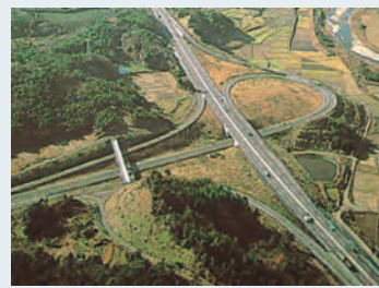
25 関JCT名古屋方向ランプ 開通(9.15) 写真
