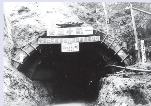
加太トンネル貫通
