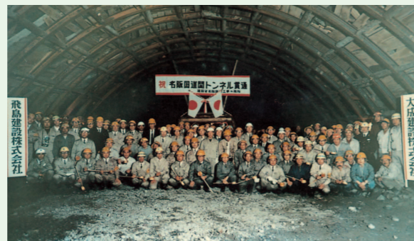
関トンネル(昭和 47 年 4 月 22 日)
