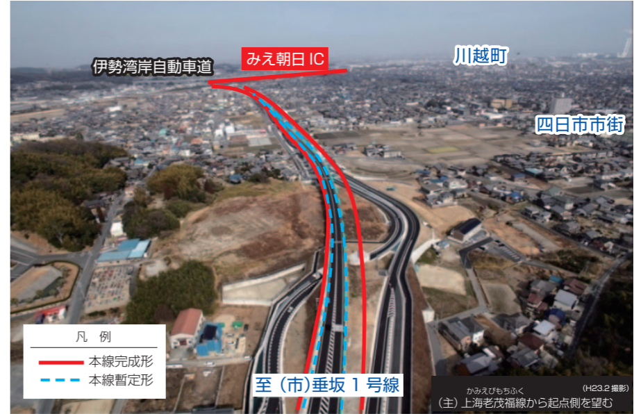
(主) 上海老茂福線付近から川越方面を望む (平成23年2月撮影)
