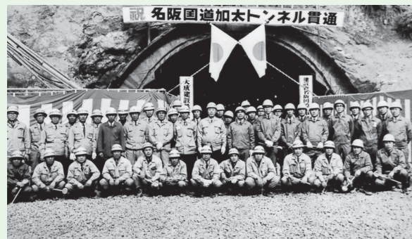
加太トンネル(昭和 45 年 4 月)
