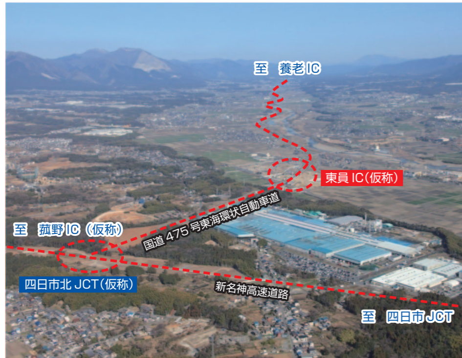
平成 27 年度開通を目指す(仮称)東員 IC(平成 25 年 3 月撮影)
