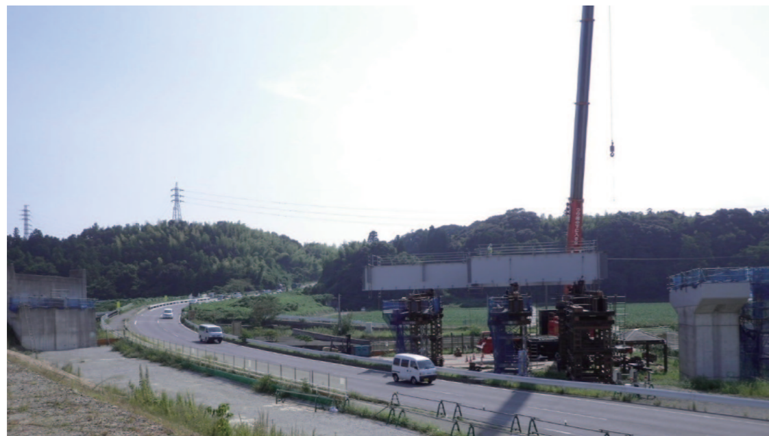
(仮称)東員 IC の橋梁架設を開始(平成 25 年 9 月撮影)
