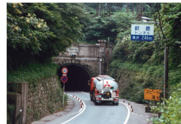
バイパス整備前の旧鈴鹿トンネル (片側交互通行)
