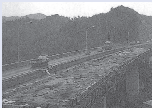
二期工事(伊賀大橋)
