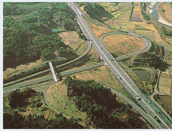
25 関JCT名古屋方向ランプ 開通(9.15) 写真
