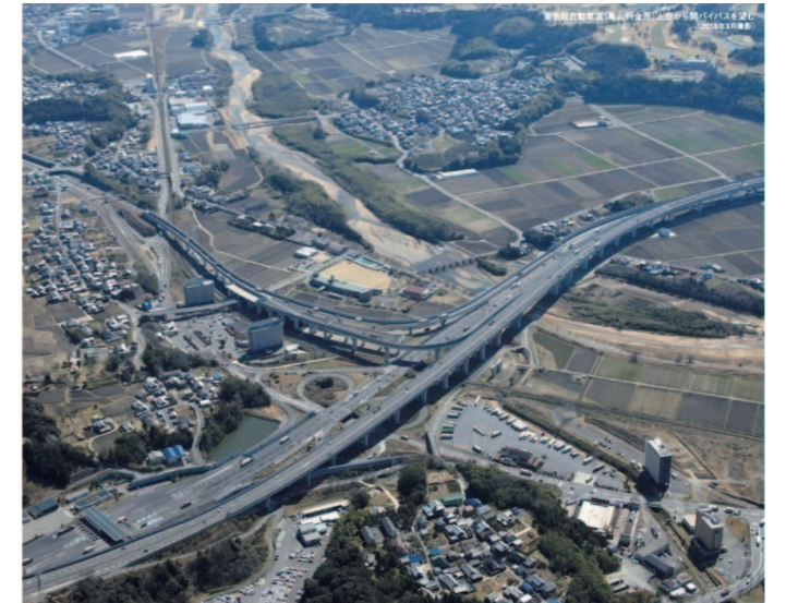
現在の関バイパスと亀山IC付近(平成25年3月撮影)
