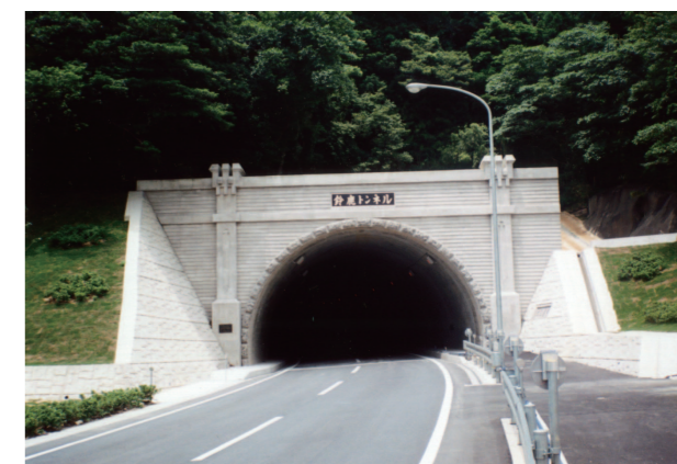
鈴鹿トンネル (三重県側)
