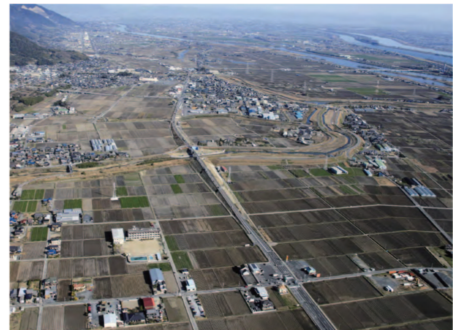
4車線化済みの桑名市下野代から大垣方面を望む(平成25年3月撮影)
