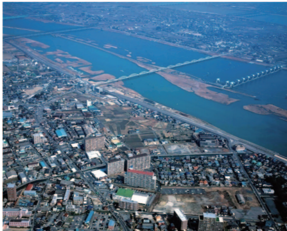
桑名市北浜町上空から伊勢大橋を望む
