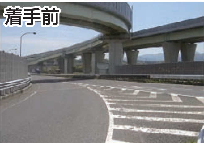
亀山跨線橋(下り)
