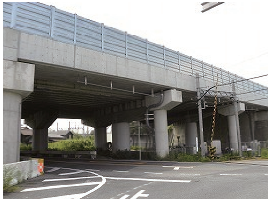
コンクリート橋
