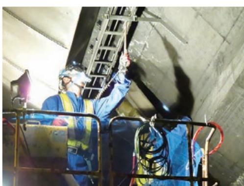
トンネル点検車を利用した打音検査
