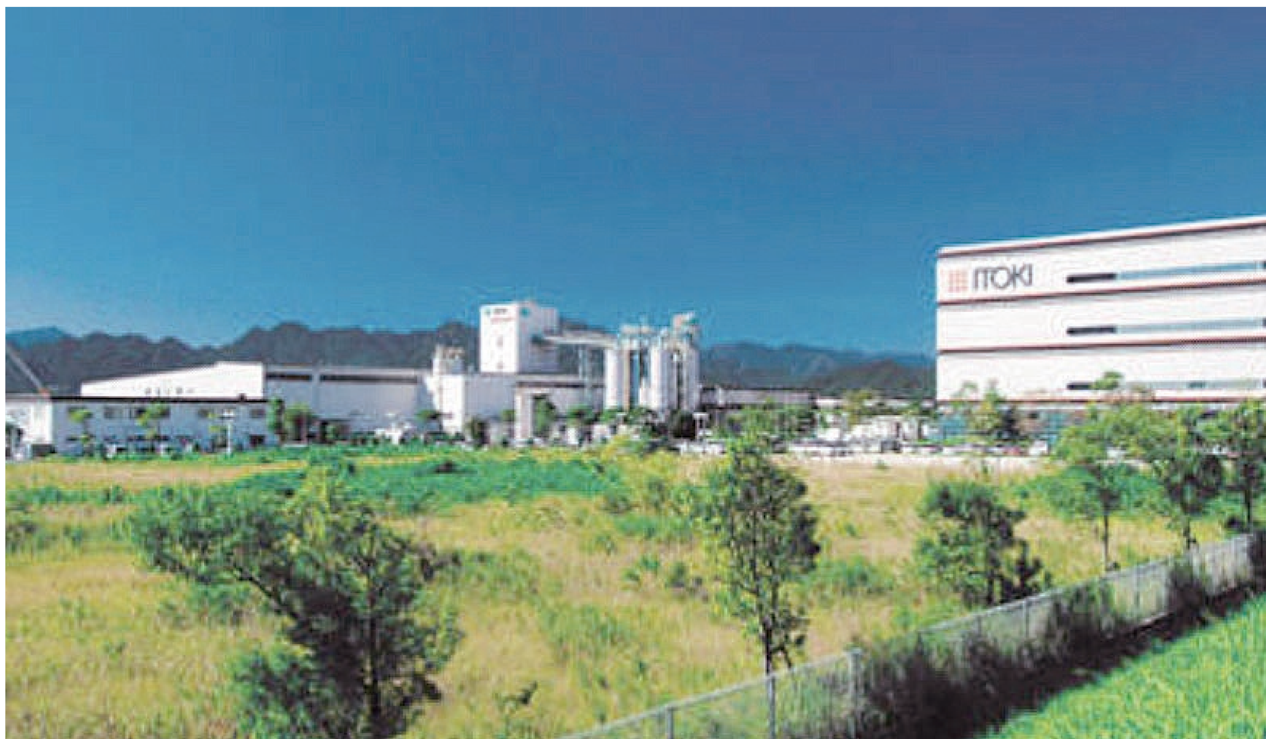
名阪亀山・関工業団地が完成 (1989)
