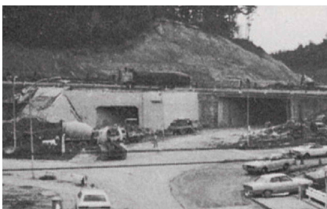
工事中の天理東IC
